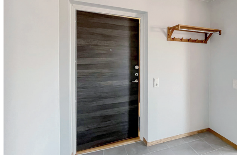
Entrégolv i grå klinker med eksocklar
